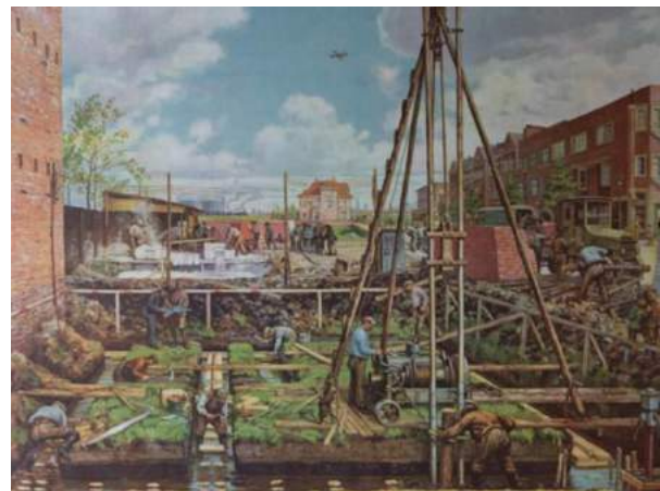
schoolplaat van een fundering met houten palen
